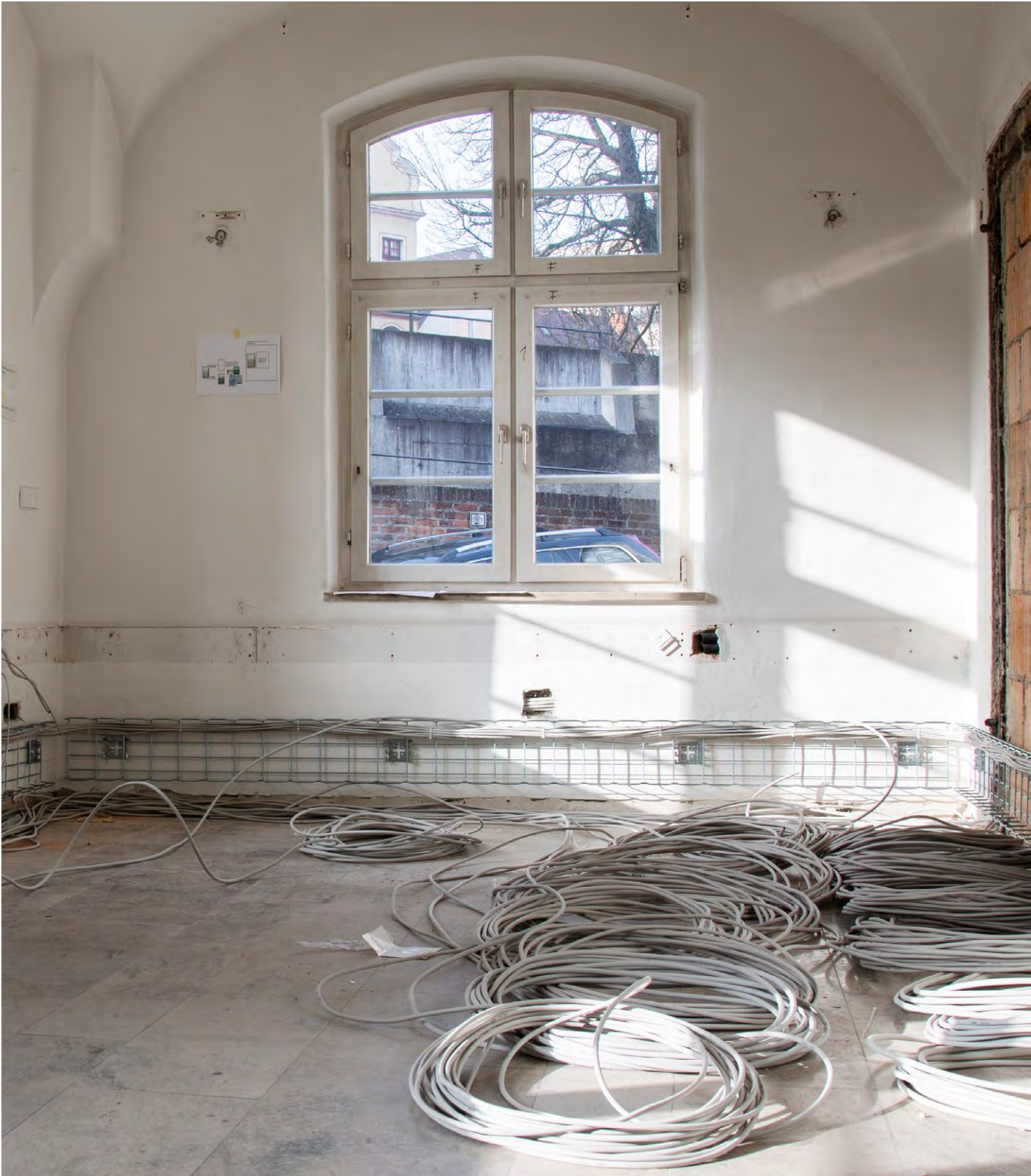
Verkabelungsarbeiten beim Aufbau des Museums „Die Einsteins“ im „Engländer“
